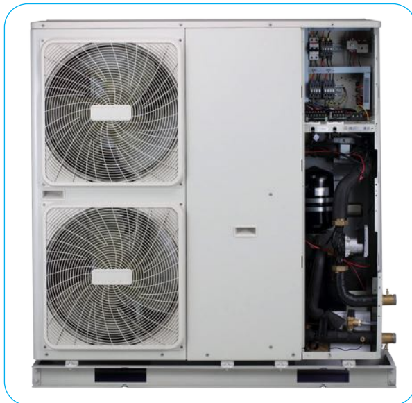
Kapı 1: Hidronik bölmelere ve elektrikli parçalara erişim
